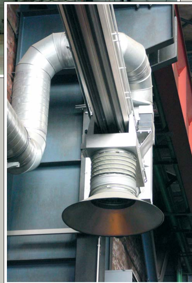
Saugschlitzkanalanlage SSK 900 mit Schwenkarm 9 m lang und darin verfahrbarem Teleskopabsaugtrichter NW 450 für 10.000 m³/h mit elektrischem Antrieb für alle drei Koordinaten. Wahlweise auch mit Funkfernsteuerung
