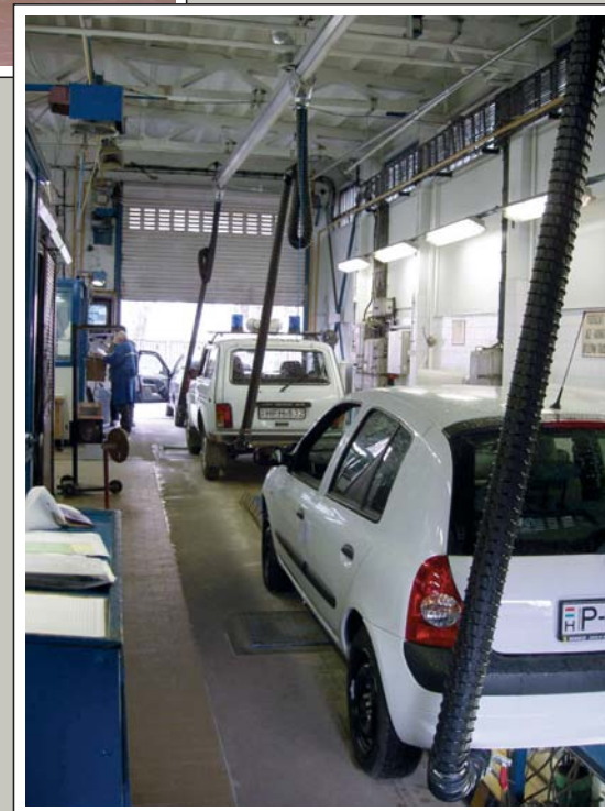
Saugschlitzkanalanlage SSK 290 als Rundlaufanlage für technische Fahrzeugüberwachungsorganisationen mit hohem Fahrzeugaufkommen bis zu 150 Fahrzeuge pro Prüfspur.
