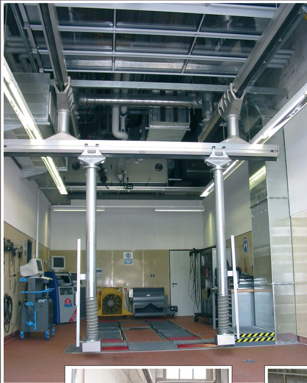
Saugschlitzkanalanlage SSK 290 im Koordinatensystem verfahrbar für PKW-Leistungsprüfstand mit einer Absaugleistung bis 4.000 m 3 /h und in Hochtemperaturausführung bis 900°C Abgastemperatur lieferbar.
