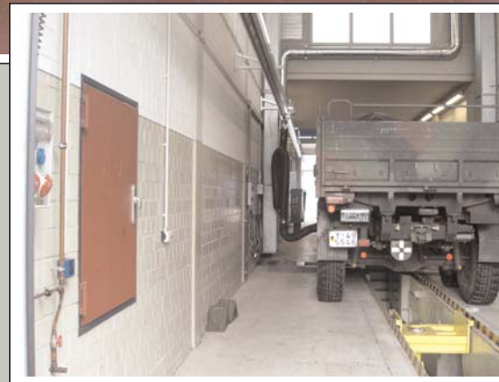
Saugschlitzkanalanlage SSK 150 als Mitfahranlage am LKW-Bremsenprüfstand mit Einzelventilator Typ FD. Wahlweise mit automatischer Schlauchablösung vom Auspuff und automatischer Rückholeinrichtung des Laufwagens über Seilzugantrieb.
