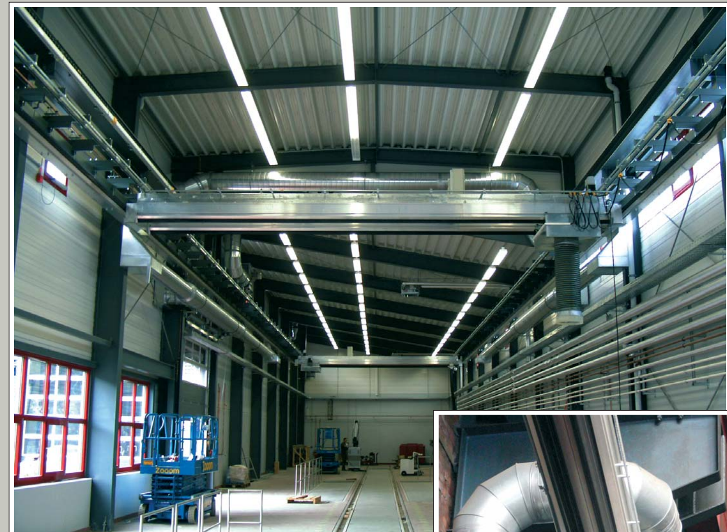
Saugschlitzkanal SSK 450 / SSK 900 im Koordinatensystem verfahrbar mit zwei Absaugbrücken für Diesellokabsaugung mit einer freien Spannweite von 12 m, längsverfahrbar 60 m. Die Anlage ist unterhalb einer Krananlage installiert und beide Systeme sind entsprechend den Sicherheitsvorschriften gegeneinander verriegelt. Die Bedienung erfolgt wahlweise über Schaltampeln oder mit Funkfernsteuerung. Die Absaugleistung kann bis 20.000 m³/h betragen.
