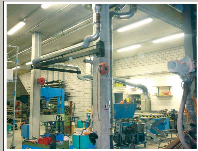
Hochflexibler Auslegerarm VARIO Flex NW 160 – 9 m lang, mit 3 Drehgelenken, montiert auf einer Säule zum Abdecken von 4 Arbeitsbereichen.
