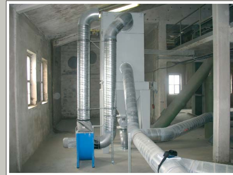
Atex-Patronenfilter – Zentralanlage 2000 m 3 /h für Absaugung im Silobereich mit Schneckenradaustrag zur Medienrückführung, einschließlich Expansionsklappe.
