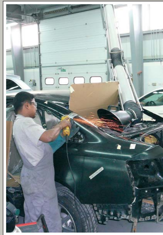
Erfassung von Funkenflug und Feinstaub beim Abschleifen von Teilen einer Autokarosserie.
