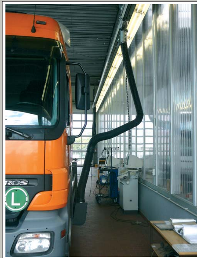
„SLS-Truck“ zum automatischen Mitführen des Erfassungselementes und Absaugung beim Mitfahren am Bremsenprüfstand in einer Mercedes-Benz LKW Werkstatt.
