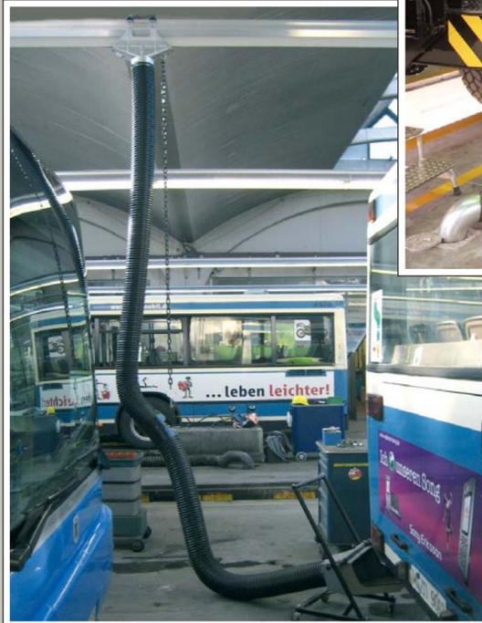
Absauganlage mit Unterfahrtrichter für Busse
