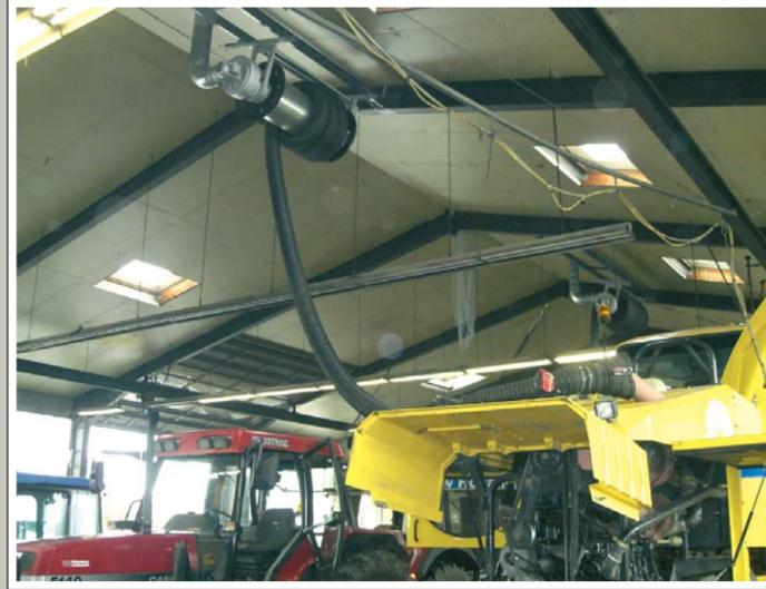
Kompaktschlauchaufroller mit Absaugventilator. Schlauchlänge 15 m
