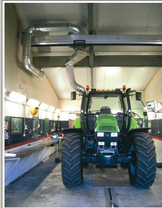
Leistungsprüfstand für Schlepper. Saugschlitzkanal SSK 450 mit Hochtemperatur-Absaugeinheit
