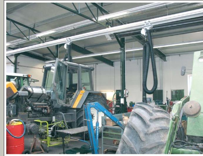
Saug Schlitzkanal SSK 290 mit 2 Laufwageneinheiten NW 100
