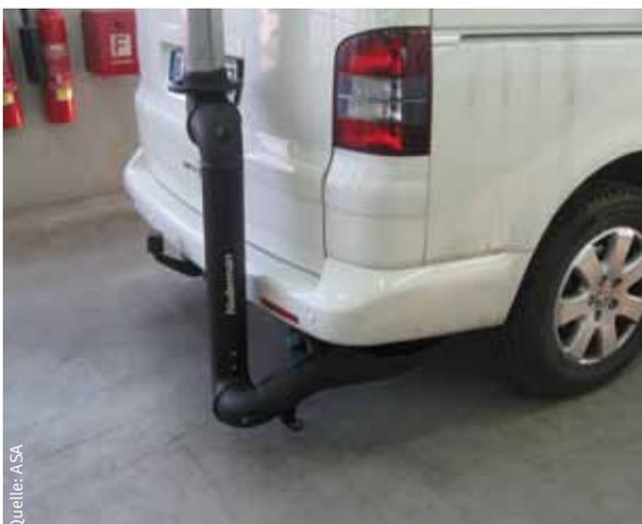
Bild links: Berührungslose Absaugeinrichtung für alle Fahrzeugtypen
